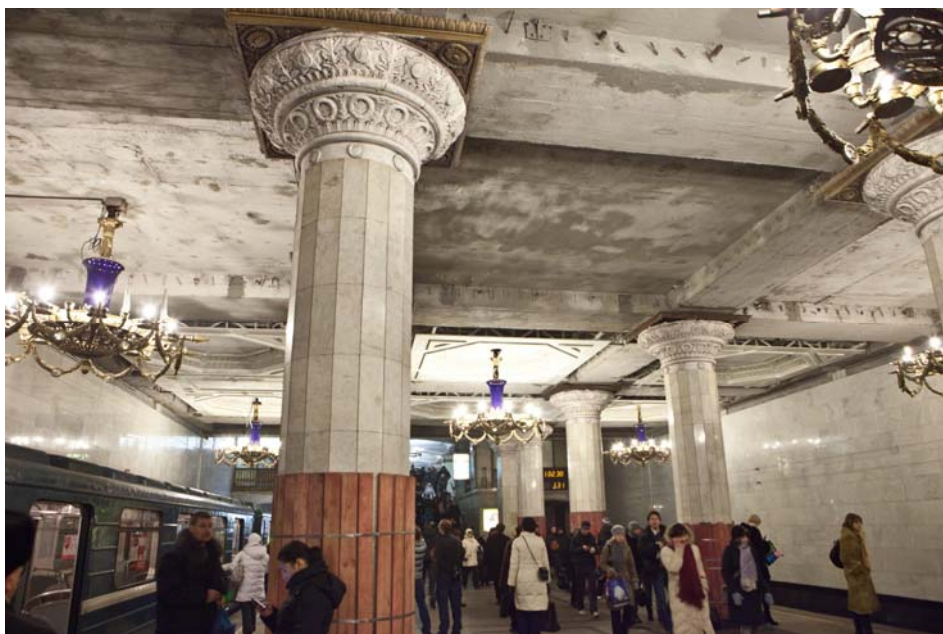
Рис. 7 – Перронный зал ст. Автово с демонтированными конструкциями подвесного потолка
